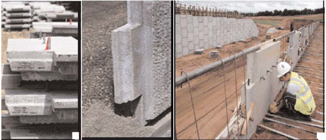
Figure I.3. Mise en place d'une rangée d'écailles et pose d'un lit d'armature.
