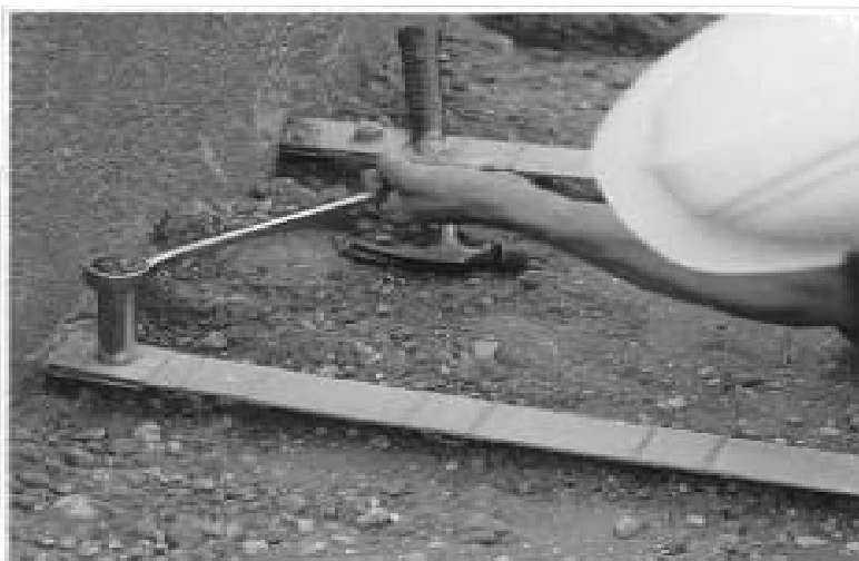
Figure I.12. Armature à haute- adhérence
