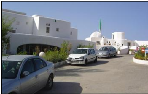
Figure 43: la voie mécanique de l'hôtel. Source : http://www.google.dz/imgres?im.gur .
