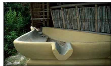
Figure 13:Lefiltrée de l'eau de pluie. Source: Jimmy CS Lim et AryaAbieta. Rapport. Pdf.
