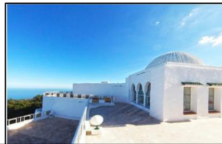
Figure 41: façade de l'hôtel. Source : https://www.google.dz/maps/uv?hl .
