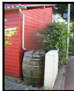
Photo n°11et12: système de récupération des eaux pluviale dans quartier Vauban.
