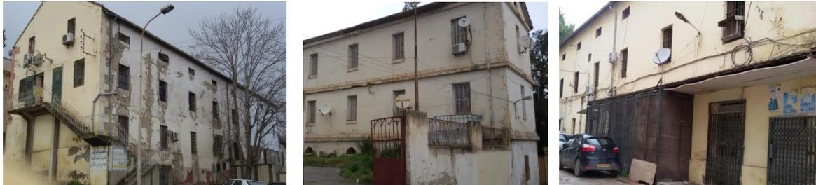
Photon° 22et23et24: l'état des façades (entre mauvais et moyen). Source : Auteur 2017
