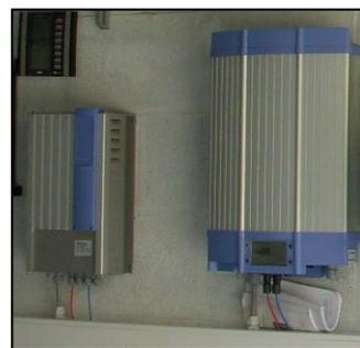
Figure n °21et 22: les onduleurs.
