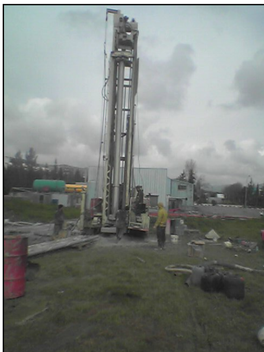
Photo VI.1 –Forage des puits d'eau a l'intérieure de l'usine (profondeur 150m)
