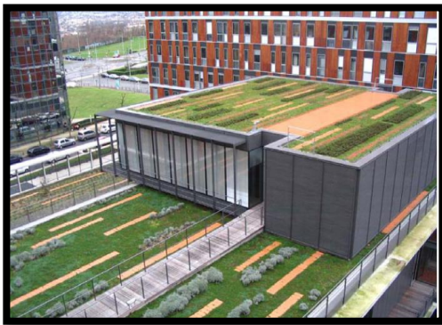
Photo 10 : Toiture végétalisée dans Bâtiment bureaux public Lieu : Noisy-le-Grand 93Pays : France
