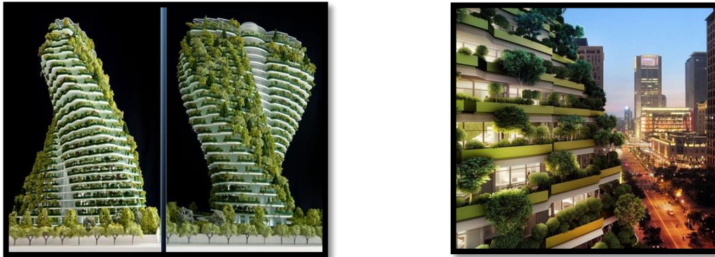
Photo 17 : TAO-ZHU garden Agora garden. TAIWAN. (Source : http://vincent.callebaut.org )
