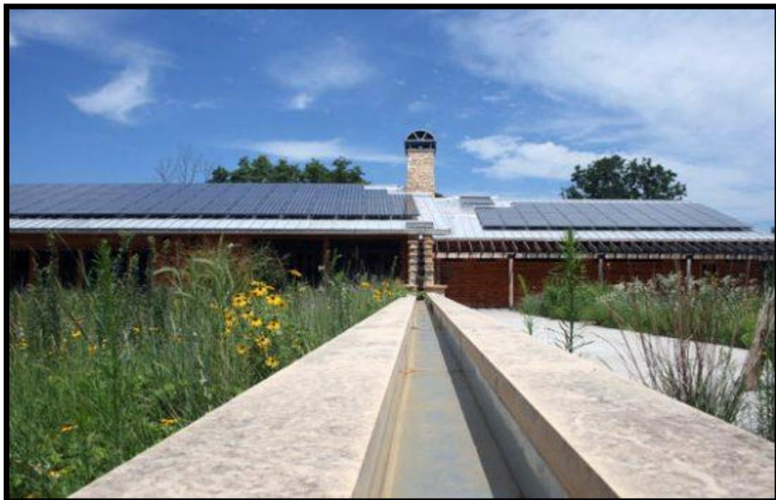
Figure I-23. Un aqueduc transmet les eaux pluviales du toit à un raingarden. source: [www.aldoleopold.org](http://www.aldoleopold.org)
