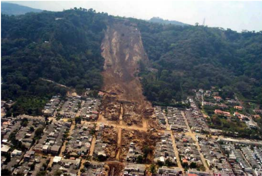
Figure. 1.1 – Glissement de terrain de Las Colinas suite au tremblement de terre au Salvador en janvier 2001.
