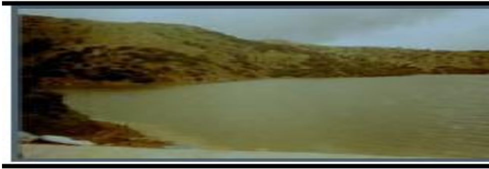
Figure 45: Barrage de Bouhamdene
