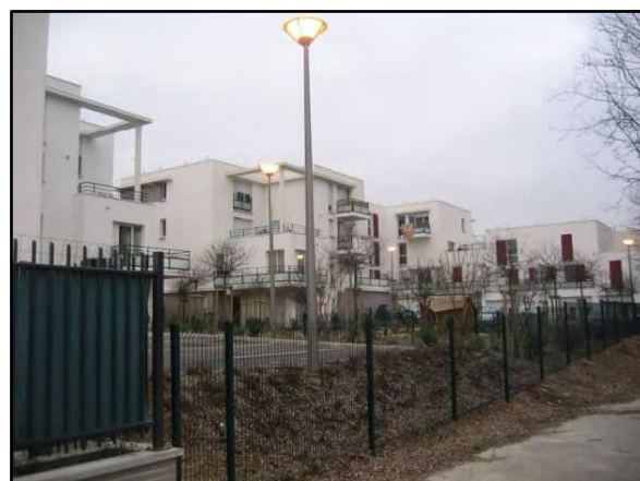
Photo 3 : Habitat en petit collectif s'apparentant à un habitat individuel superposé
