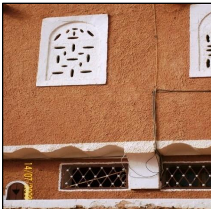
Photo 12 : Protection des ouvertures et texture rugueuse Source : CHABI M, Dahli M. Une nouvelle ville saharienne sur les traces de l'architecture traditionnelle. Tizi-Ouzou, Département d'architecture de l'université Mouloud Mammeri, 2011, 10p.
