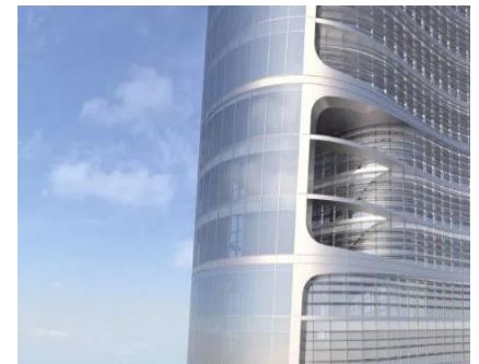
Figure 74 : Mur Rideau de tour
