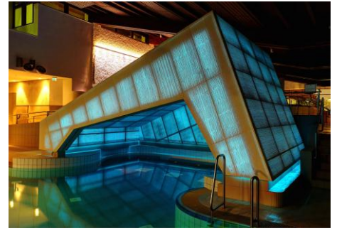
Figure 16 : Construction en béton transparent
