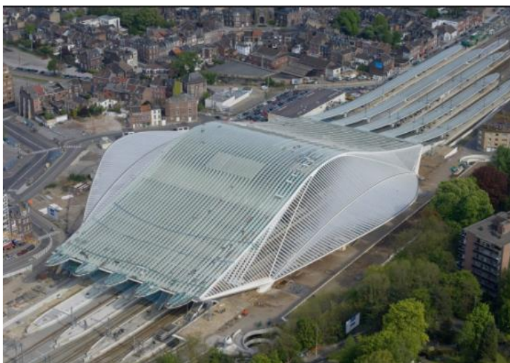
Photo 34 : Vue d'une façade de la gare
