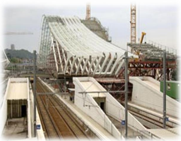
Photo 36 : Vue de loin sur les abris des quais
