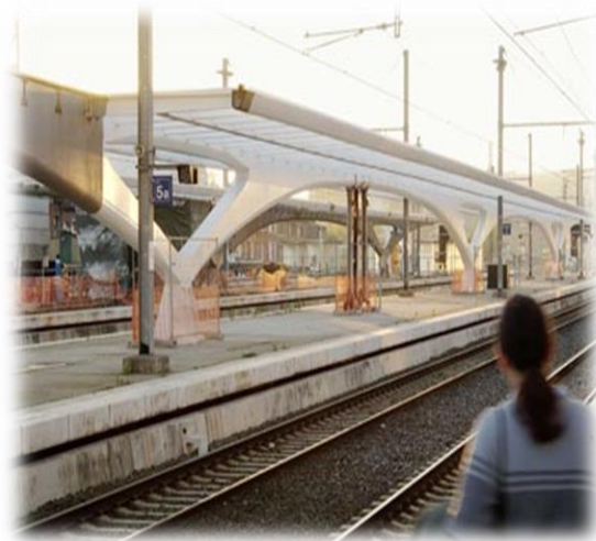
Photo 35 : Vue de près sur les abris des quais
