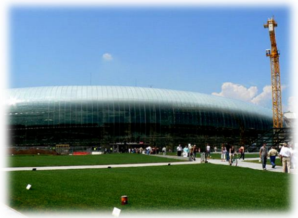
Photo 29 : La nouvelle verrière de la gare dans la façade
