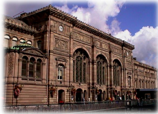
Photo 27 : Façade de la gare avant l'ajout de la verrière
