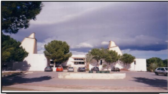
Photo 5 : Facade principale Source l'auteur
