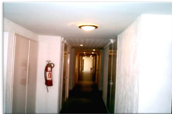
Photo 12 : Hall de distribution. Source l'auteur
