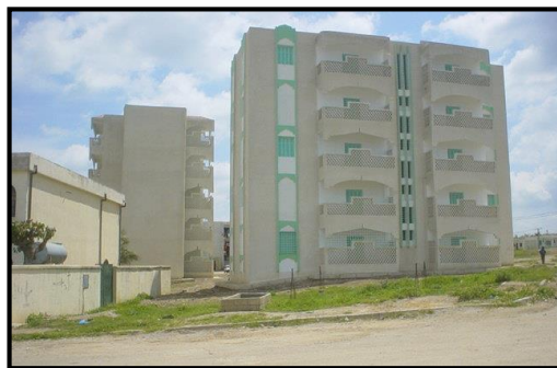
Figure 57: Habitat collectif fraîchement réalisés
