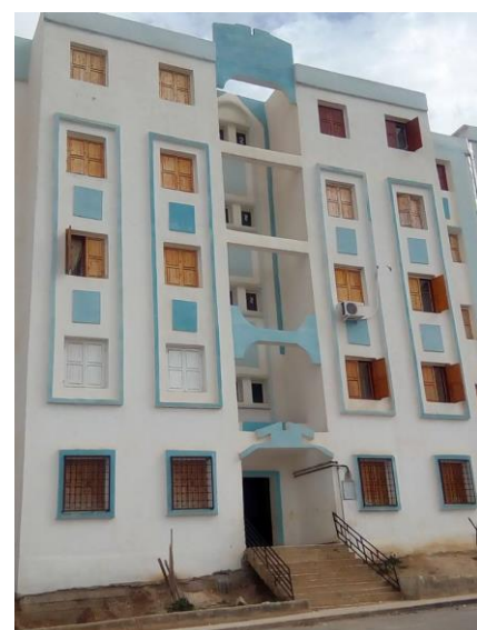
Figure 34 Photo d'entrée du bloc (Source : Auteur)
