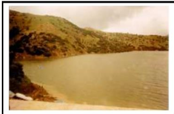
Figure 34 Barrage de Bouhamdene
