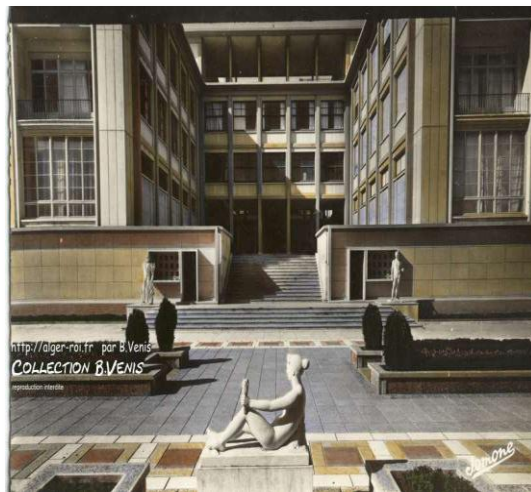
Figure 55 la façade principale de l'école
