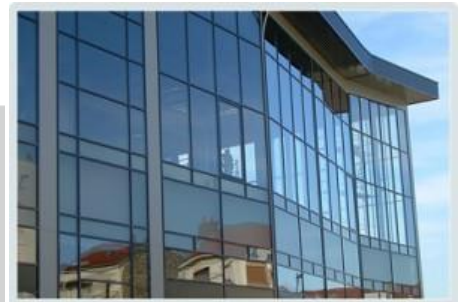
FIGURE 19: VITRAGE EXTÉRIEUR COLLÉ (VEC)
