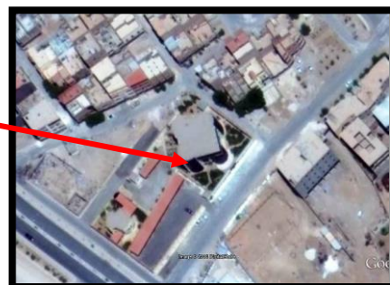
figure 33: la position de l'immeuble de bureaux dans le Contexte urbain Source : Google Earth , 2016)
