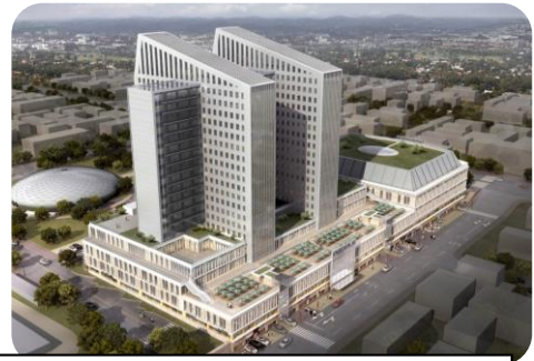
Figure82 : :park mall Sétif (en chantier)
