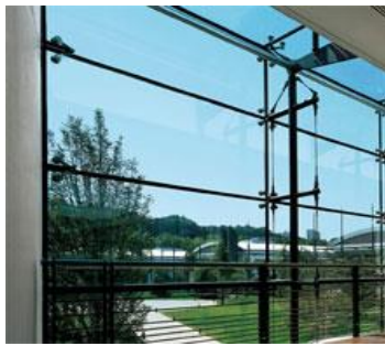
FIGURE 17 : VITRAGE EXTÉRIEUR ATTACHÉ (VEA) SOURCE ( HTTP://FECAMP-SERVICES.COM/BLOG/FACADES-VITREES )
