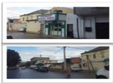
Figure 14 :Les habitations coté sud de la gare Source : l'auteur
