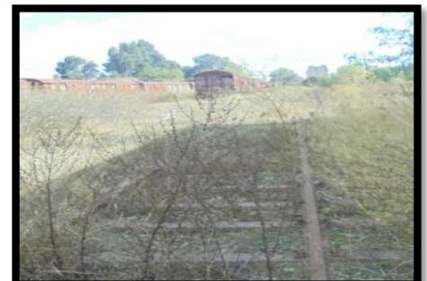
Figure 20 : l'ancien chemin de fer Source : personnelle
