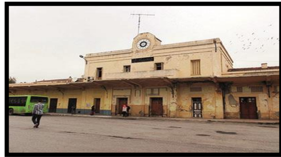
Figure 8 : bâtiment de la gare
