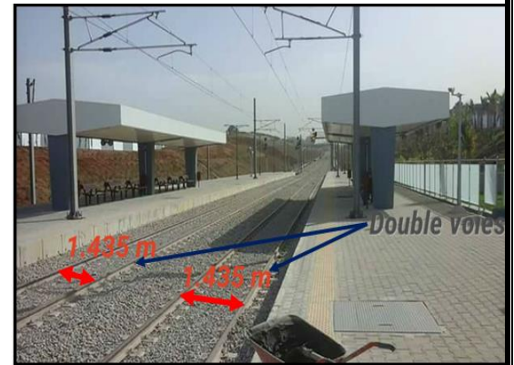
Figure 18 : la ligne ferroviaire de ZERALDA
