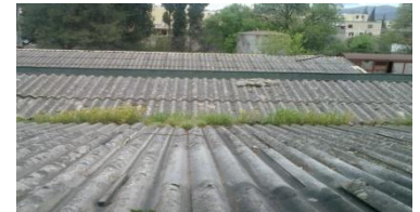
Figure 19 : toiture de la gare
