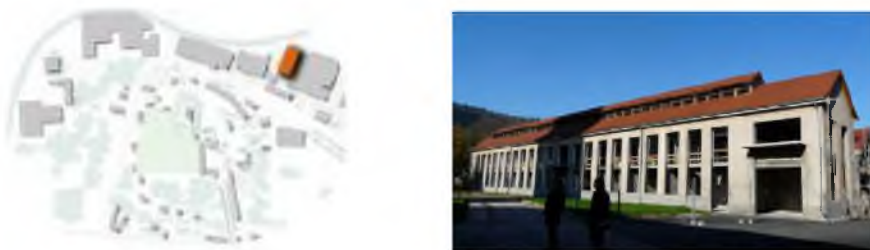
Fig12 : ateliers en cours de rénovation - 2008
