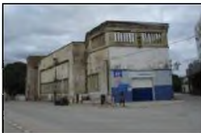
Bâtiment d'angle- Façade Est- état actuel
