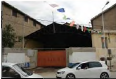
Figure 61 : Passage couvert n°2 Façade principale
