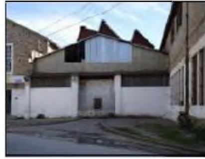
Figure 59 : passage couvert n°1 Façade principale
