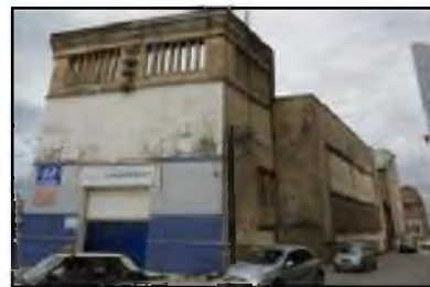
Bâtiment d'angle- Façade Ouest- état actuel
