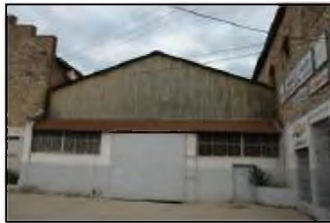
Figure 65 : Façade secondaire n°3
