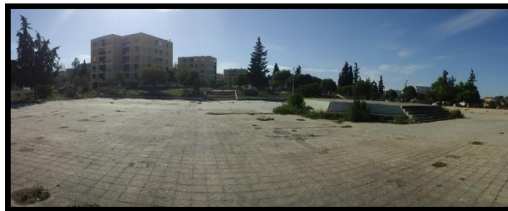
Figure 4.9 : Photographies montrant l'état du mobilier urbain Source : auteur
