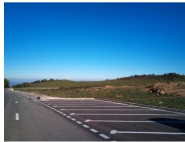
Photo2 : parking à l'extrémité de la route
