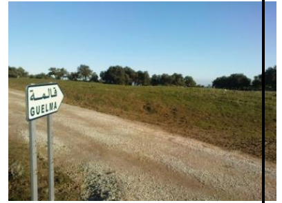
Photo3 : route en mauvaise état
