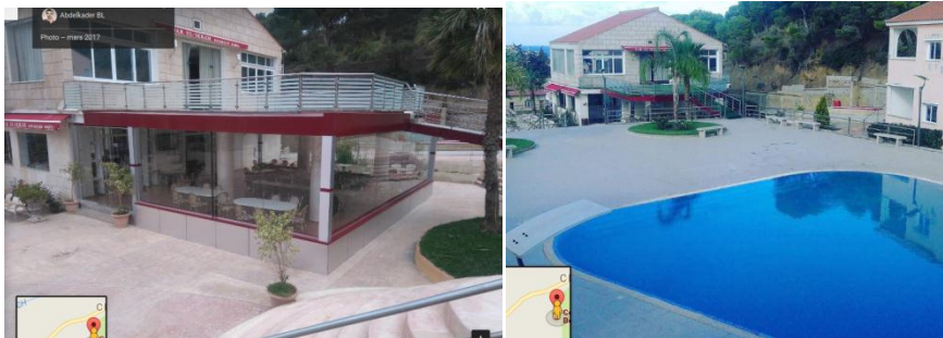
Photo 3 le restaurant du complexe photo 4 la piscine du complexe
