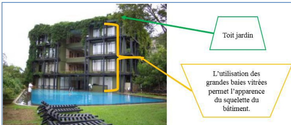
Photo 2 : façade de l'hôtel
