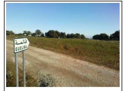
Figure 71: Route en mauvais état Source : Auteur, 2018
