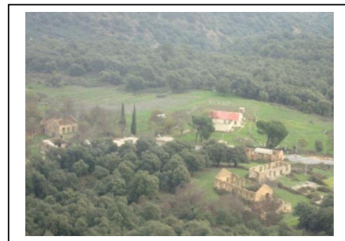
Figure 67: les ruines du camp français Source : Elaggoune Med A
