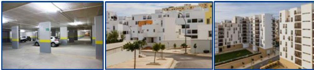
Des galeries et des parkings
