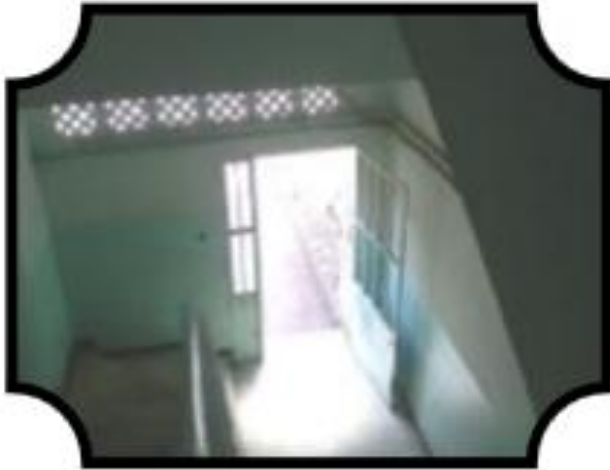
Figure 59 : Vue sur cage d'escalier
