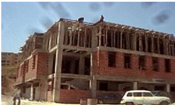
Figure24 : Chantier de construction d'une mosquée, programmée dans le cadre de POS.
