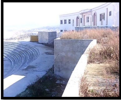
Figure98 : Le béton armé des murs de soutènement
