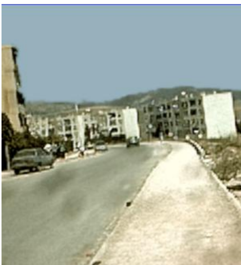
Figure 22 : revêtement de routes et de trottoirs, dans le cadre d'opération d'embellissement
