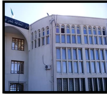
Figure99 : le vitrage des fenêtres
