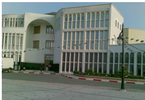
Figure79 : Maison de la culture Site : https://abbassa.wordpress.com/
