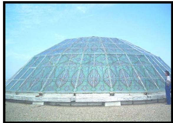
Figure 96 : le vitrage de la coupole Site : www.detail-guide/
