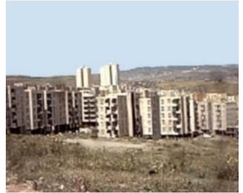
Figure 15: vue d'ensemble de la ZHUN de Boussouf,
