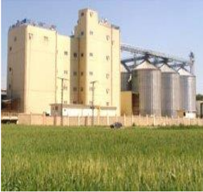
Figure (1.1) : Les silos des moulins
