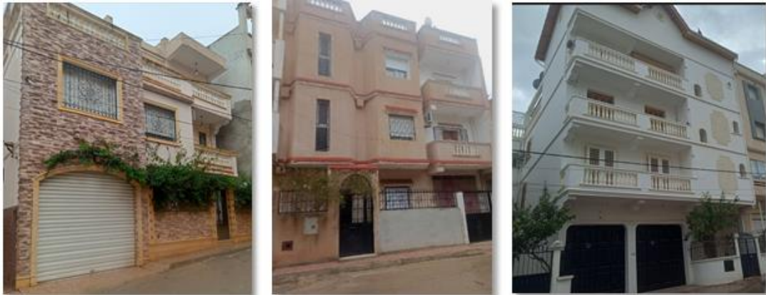
Figure IV. 31 : différentes hauteurs des habitations individuelles de lotissement 19 juin, Source : Auteur (2023)
