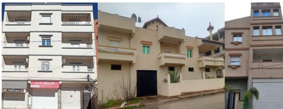
Figure IV. 35 : différents types de vitrage utilisée dans les fenêtres des habitations individuelles de lotissement 19 juin , Source : Auteur ( 2023)
