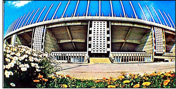
Figure VII.14: Stade 5 juillet, vue depuis l'extérieur. Source: (COJM, 1975)
