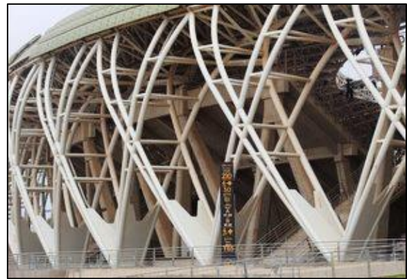
Figure IX.7: photos du stade olympique Miloud Hadfi depuis l'extérieur. Source : Auteure
