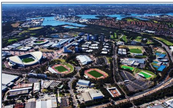
Figure IV.3: Vue aérienne du Parc olympique de Sydney montrant certaines de ses installations sportives. Source : © Simon Clancy / Dreamstime.com
