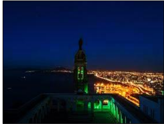
Figure IX.18: Mise en lumière du Fort de Santa Cruz. Source DTA Oran.
