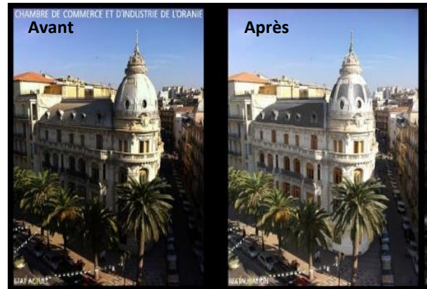
Figure IX.14 : immeuble de la chambre de commerce avant et après réhabilitation boulevard de la Soummam. Source : OPGI Oran
