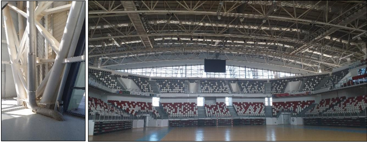
Figure IX.32: En haut : photos de la salle OMS du complexe sportif depuis l'extérieur. En bas : à droite, vue de l'intérieur ; à gauche, détail de la structure. Source : Auteure 2025
