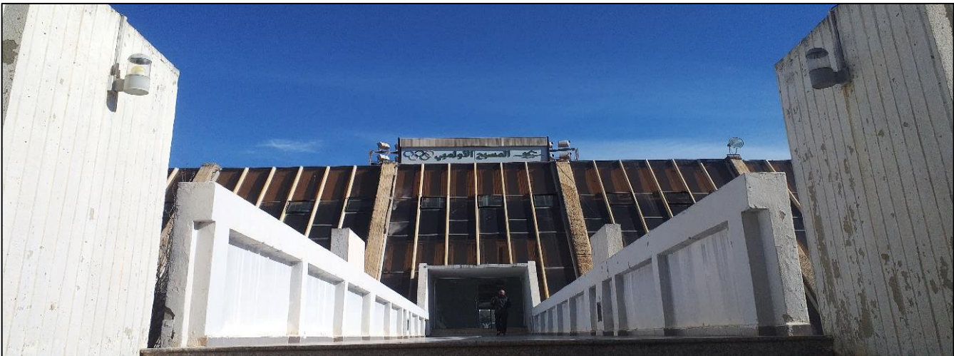
Figure IX.30: photos montrant le centre nautique depuis l'extérieur. Source: Auteure 2025
