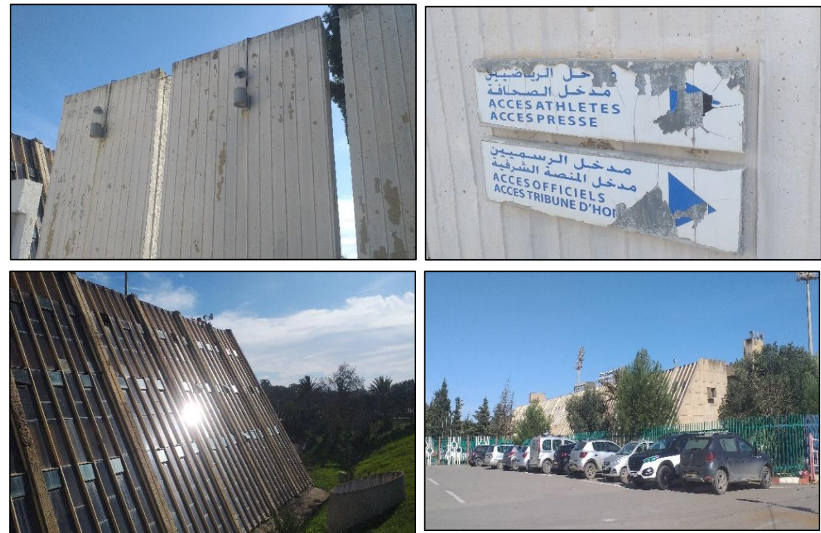
Figure IX.29: Photos montrant la salle OMS la coupole. Source: Auteure 2025
