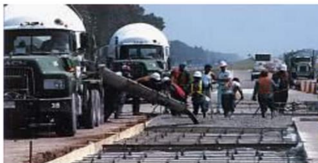
Figure 1 39: Construction des pistes des bases aériennes en utilisant le ciment PYRAMENT [5].
