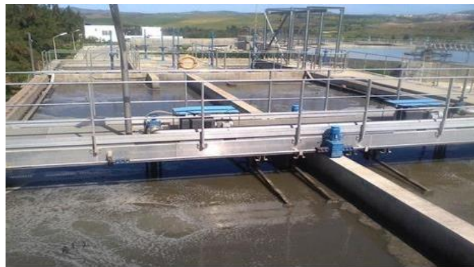
Figure I.27 : Dessablage – Déshuilage
