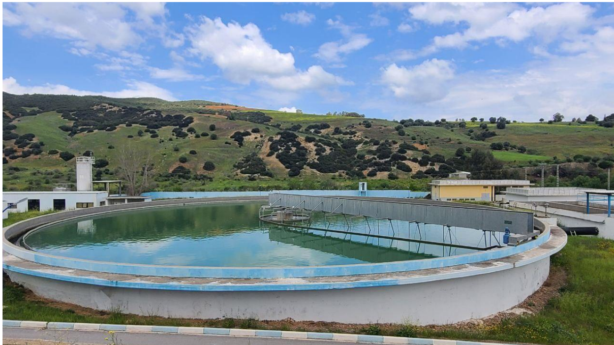
Figure II.2 Bassin de décantation.
