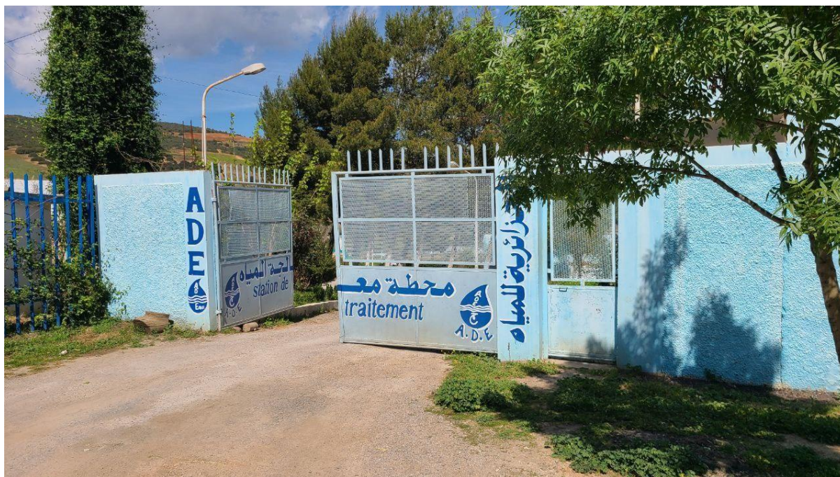
Figure I.2 Entrée de la Station de traitement des eaux Hammam Debagh
