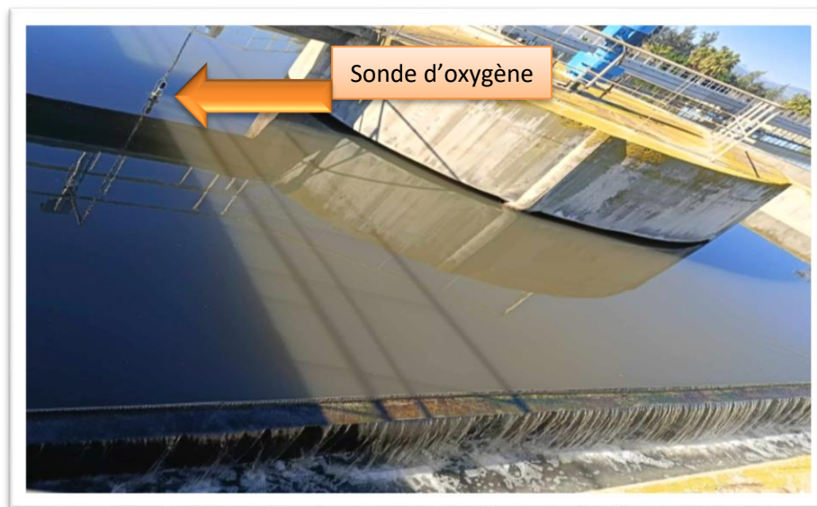
Figure 08: Décantation biologique (2025).
