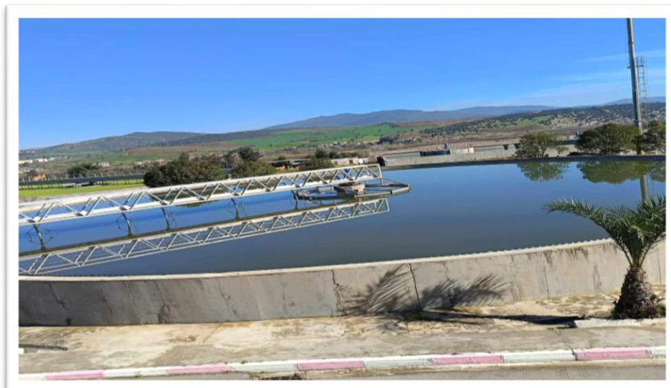
Figure 07: Décanteur primaire (2025).
