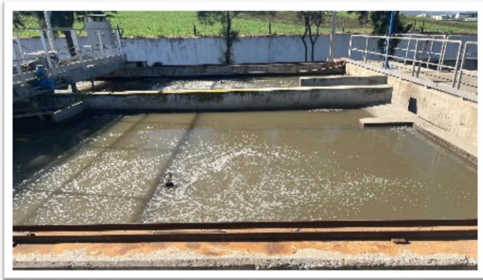
Figure 06: Dessablage-déshuilage (2025).
