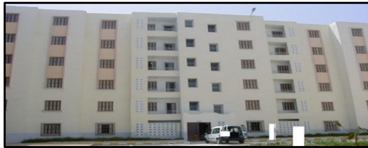
Figure 109 : Vue extérieure du site d'étude ; Source : (Gramez et al., 2021)
