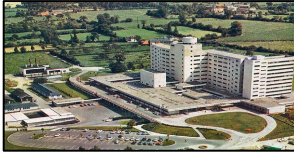
Figure 62 : L'hôpital bloc mémorial France-États-Unis de Saint-Lô ; Source : https://www.wikimanche.fr/
