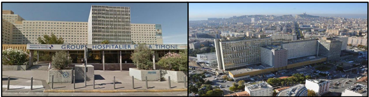
Figure 73 : Des illustration qui montre le choix du site d'implantation à gauche et le l'architecture extérieur de l'hôpital de la Timone AP-HM à Marseille ; Source : https://etablissemments.fhf.fr/ ; https://www.pharmacieduvillage.eu/
