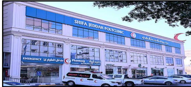
Figure 77 : Polyclinique Shifa à Jeddah ; Source : https://shifajeddah.com/vision-mission/
