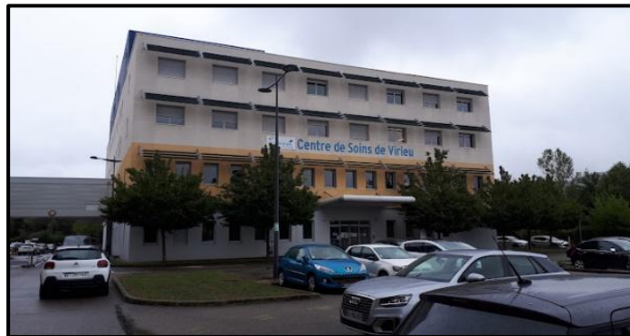
Figure 76 : Centre des soins De Virieu à Bourgoin-Jallieu ; Source : https://www.orsac.fr/
