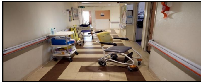
Figure 72 : une image qui montre des dégradations au niveau des matériaux et au niveau des équipements à l'hôpital de la Timone AP-HM à Marseille ; Source : https://france3-regions.francetvinfo.fr/
