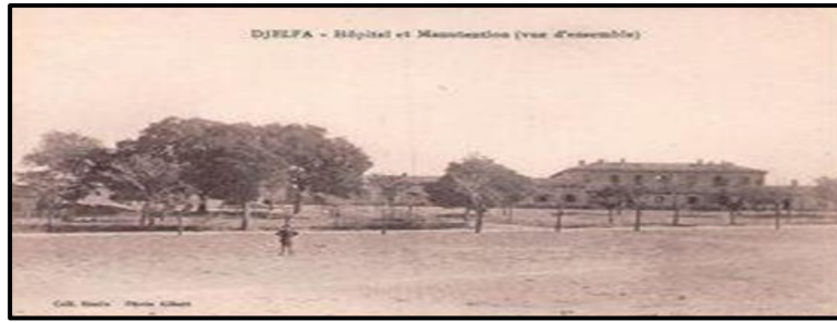
Figure 83 : Construction de l'hôpital à Djelfa de 130 lits dans le cadre de séduction de la population du Sud Algérien en 1918 ; Source : Bouaziz, s. d.
