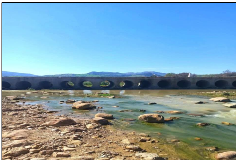
Figure 17 : Vu générale de la station 2 (Semaali. 2025)
