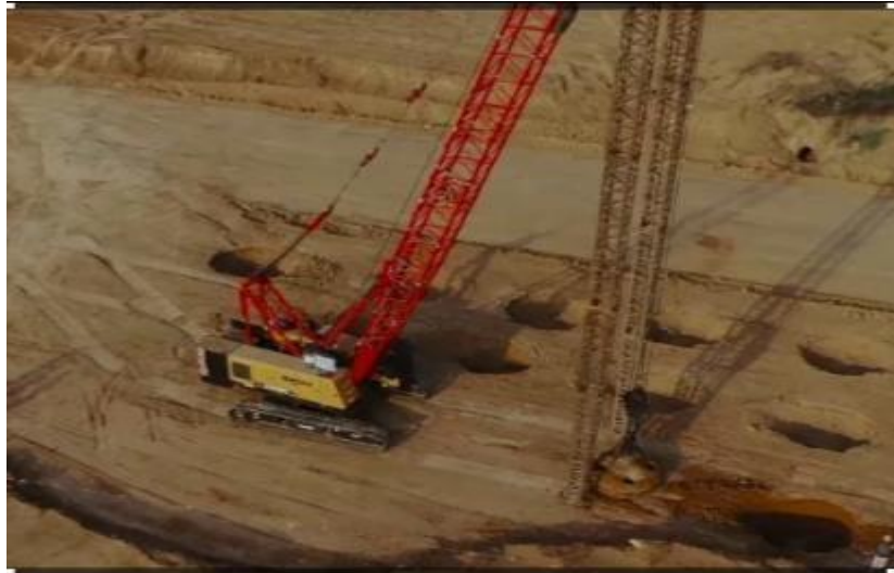
Figure II.2. Compactage dynamique.
