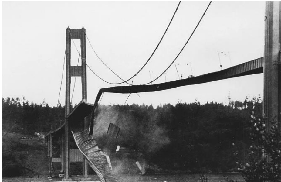
Figure III. 14: Le pont de Tacoma Narrows pendant son effondrement, illustrant un cas catastrophique d'instabilité
