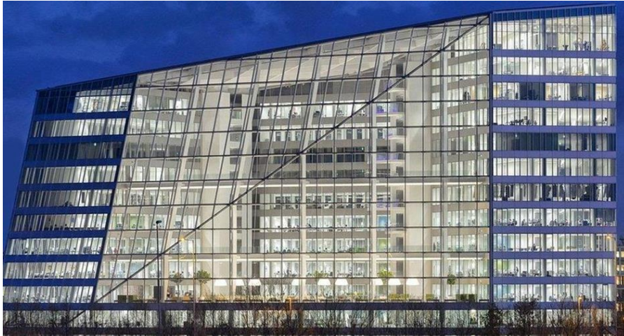
Figure III.5: Sols piézoélectriques à « The Edge » (Amsterdam, Pays-Bas) [Net 44].
