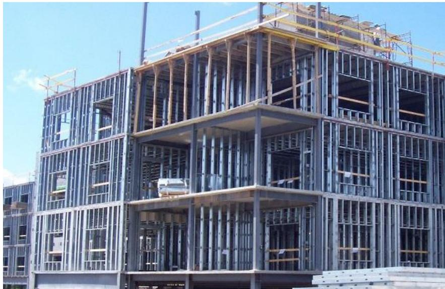
**Fig.I.2 : Bâtiments à structure métallique. [Site 4]**
