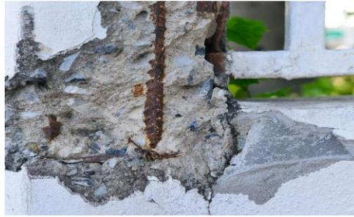
Figure 2.1 : Dégradation du béton [3].
