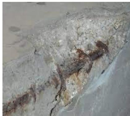
Figure 2.14 : Piqure profonde causée par une attaque de chlorure [5].
