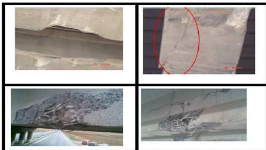
Figure 2.3 : Les différentes dégradations causées par le choc [5].
