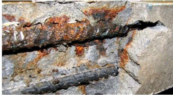
Figure 2.17 : Corrosion des armatures dans le béton [34].
