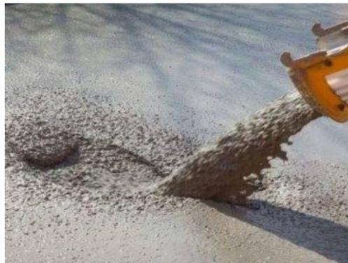
**Figure 1.33:** Béton auto plaçant [62].
