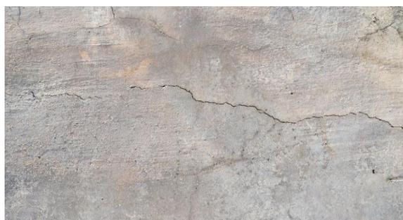
**Figure 2.4 :** Fissuration du béton due au Retrait [3].
