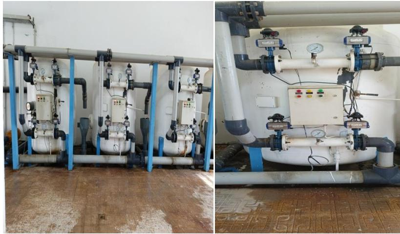
**Figure 3. 4:**Photos des filtres à sable à la station de dessalement d'Ouled Djellal
