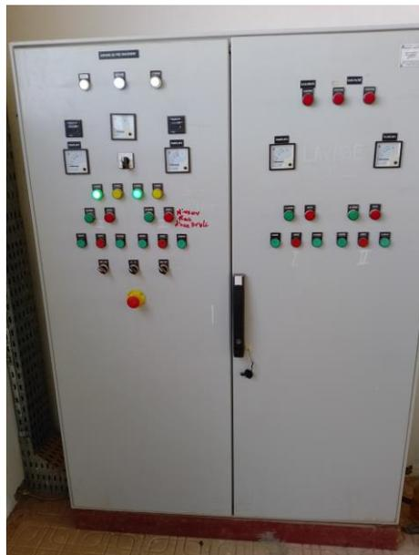
**Figure 4. 24:** Armoire de commande du système de prétraitement : eau brute + filtres à sable (station de Ouled Djellal) -armoire fermée-
