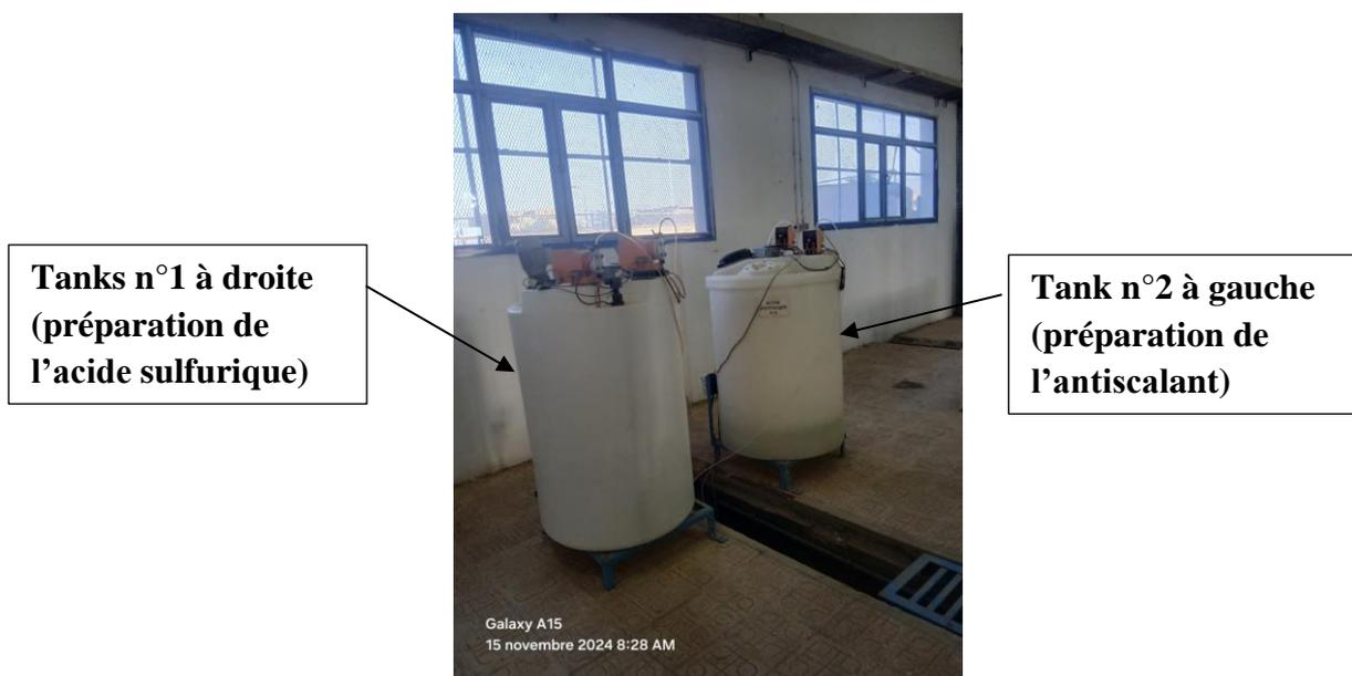
**Figure 4. 22:** Préparation des réactifs à la station de dessalement de Ouled Djellal
