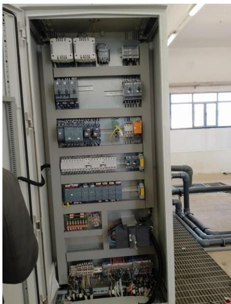
**Figure 4. 25:** Armoire de commande du système d'osmose inverse (station de Ouled Djellal) - armoire ouverte-
