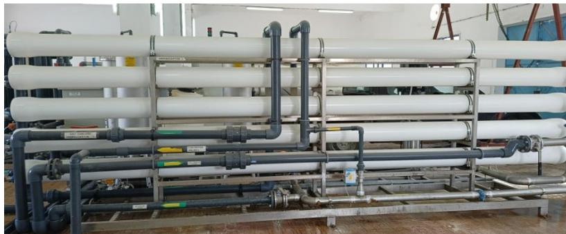
**Figure 3. 8:** Vue réelle du système d'osmose inverse – Station de dessalement d'Ouled Djellal
