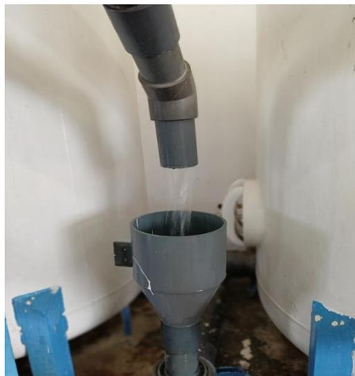
**Figure 3. 6:** Photo du système de lavage à contre-courant des filtres à sable
