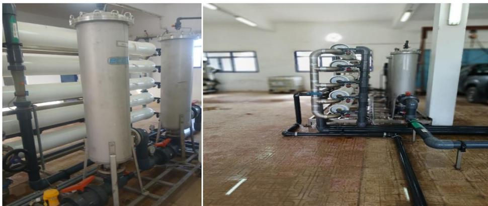
**Figure 3. 7:** Photos du système de microfiltration à cartouches – Station de dessalement d'Ouled-Djellal
