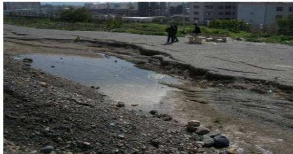
**Figure 3 :** Affaissement du terrain et stagnation des eaux
