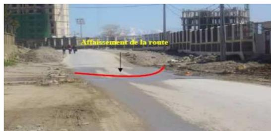
**Figure 4 :** Affaissement et bombement de la chaussée.
