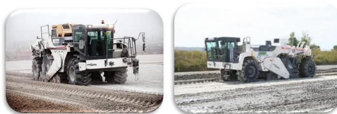
Figure 3. 4 : Traitement chimique à la chaux et au ciment.
