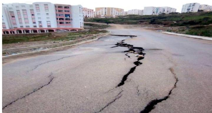
**Figure 1** Fissures, tassements sur la plateforme du stade
