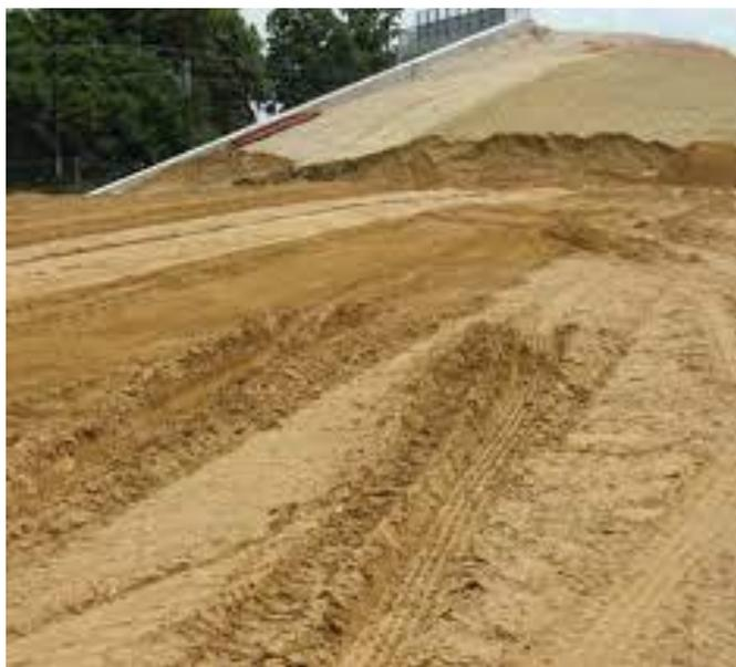
*Figure I.14 Les remblais contigus aux ouvrages*
