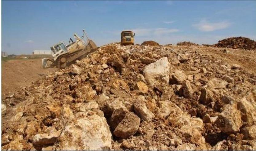
*Figure I.13 Remblais pour terrassement routier*
