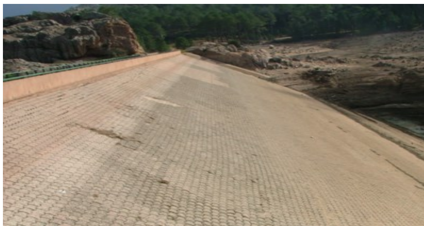
Figure 2.37 : Talus amont avec protection par pavés autobloquants [a]
