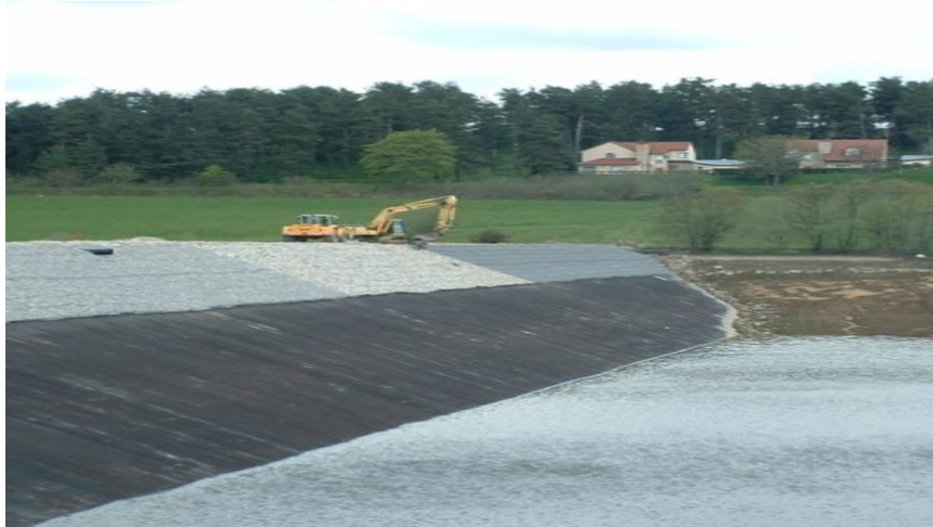
Figure 2.36: Talus amont avec protection par matelas Reno [a].
