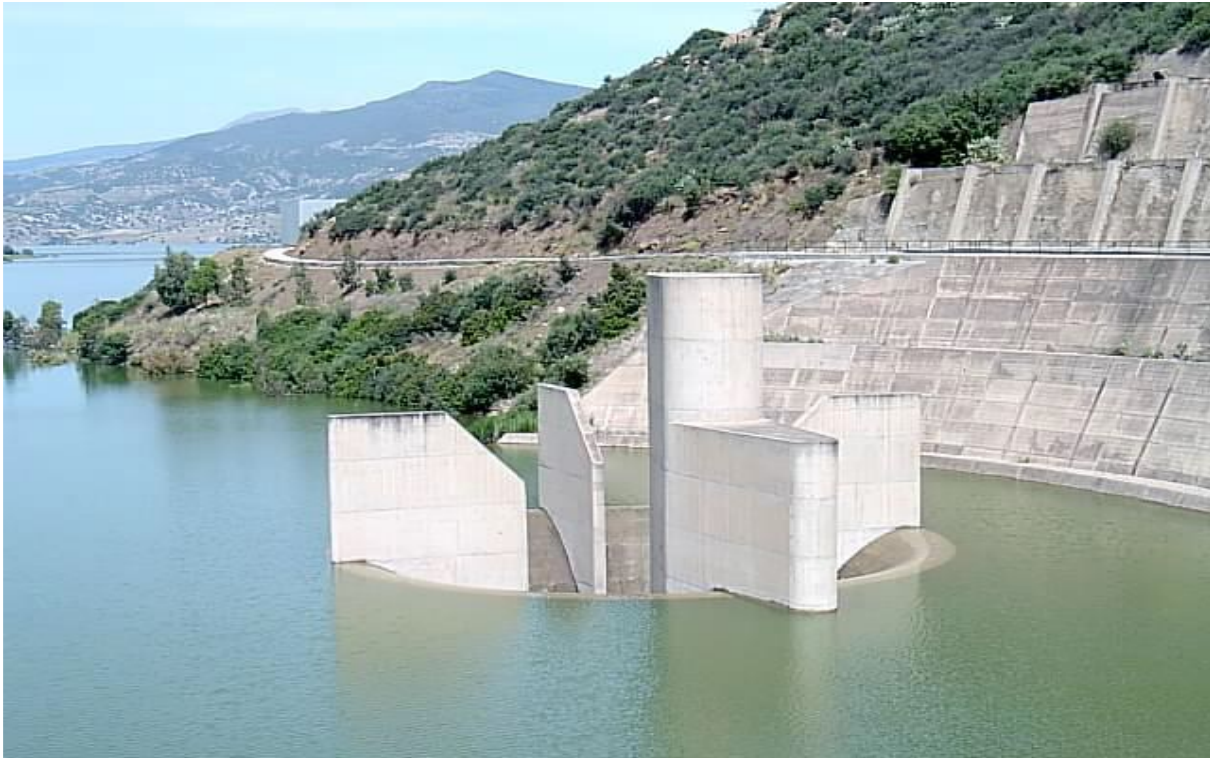
Figure 3.10: barrage Hammam Debagh : évacuateur de crues de type Corolle et Seuil . [17]
