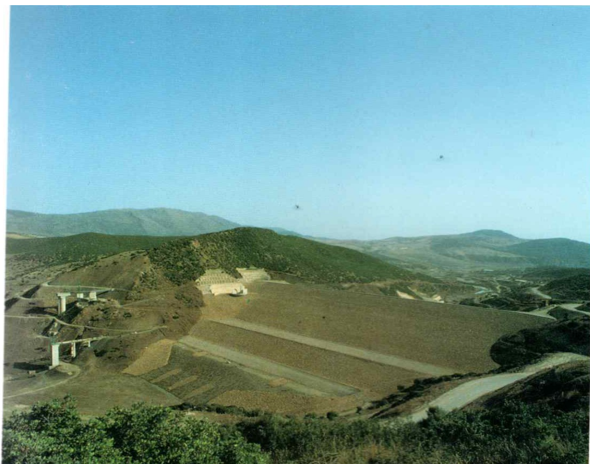
Figure 3.15 : Vue générale d'amont du barrage hammam debagh [11]
