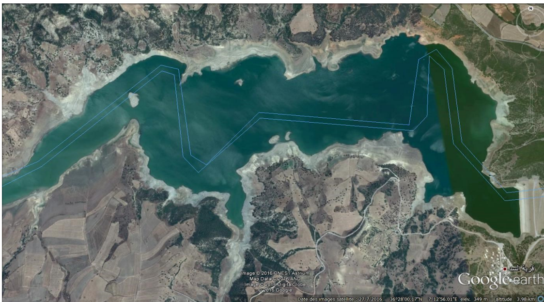
Figure 3.6: Vue par satellite de la situation du barrage hammam debagh (Google Earth).
