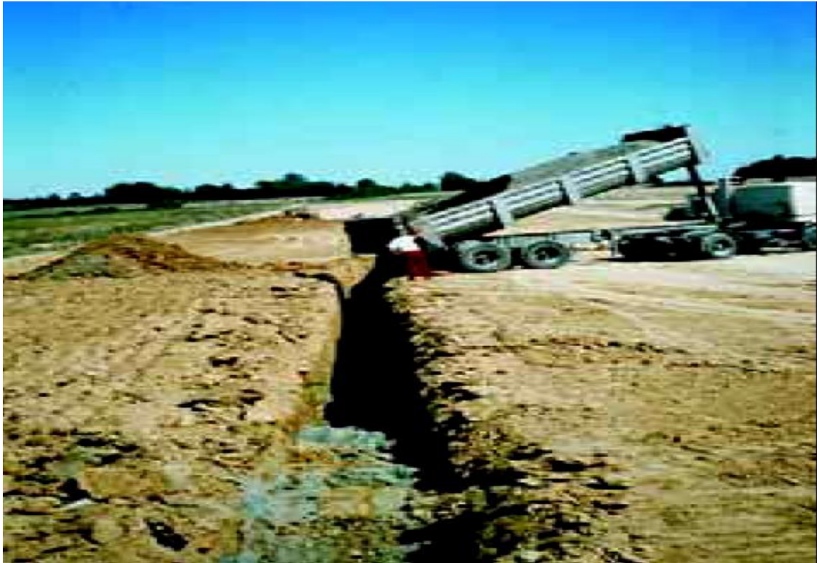
Figure 2.22 : Drain vertical recreusé dans le remblai et remplissage par du sable Drainant et auto filtrant
