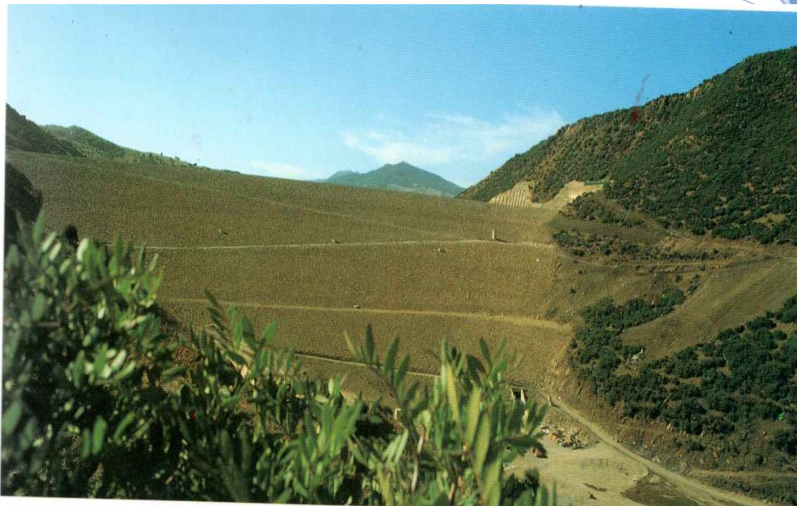
Figure 3.14 : Vue aval barrage hammam debagh.[11]
