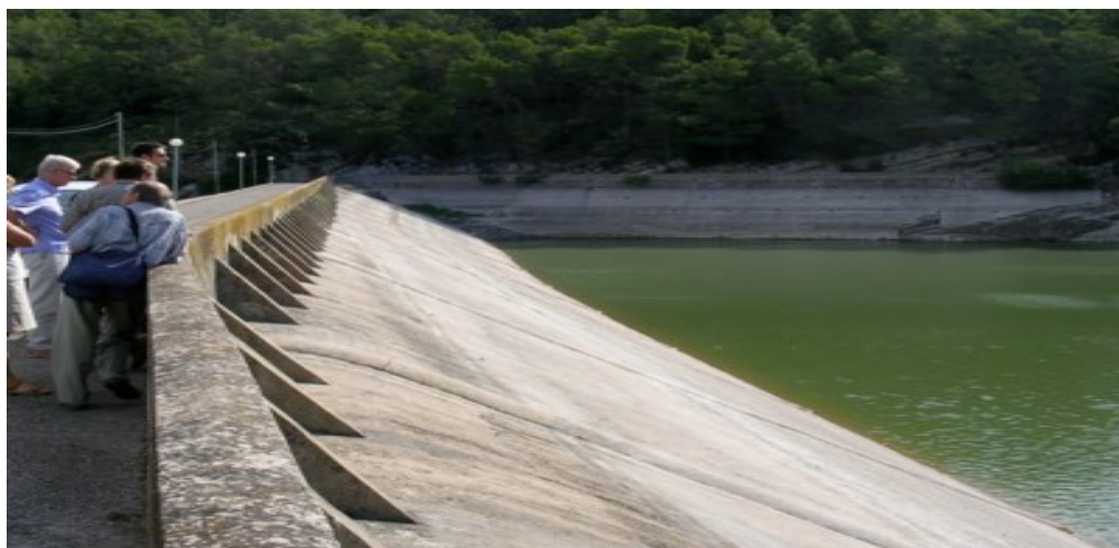
Figure 2.35 : Barrages de Carces - vue de la protection du talus amont par dalles béton - [a]
