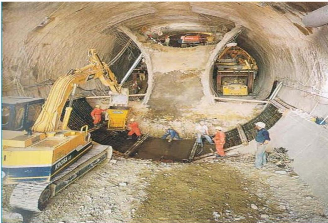
Figure 3 : Creusement en section divisée.
