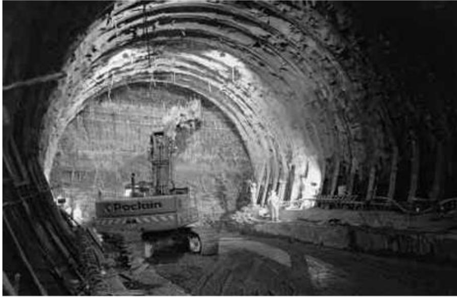
**Figure 1 : Creusement en section pleine.**
