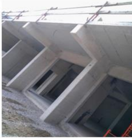
Figure II.14 : Poutre en console en béton armé [68].
