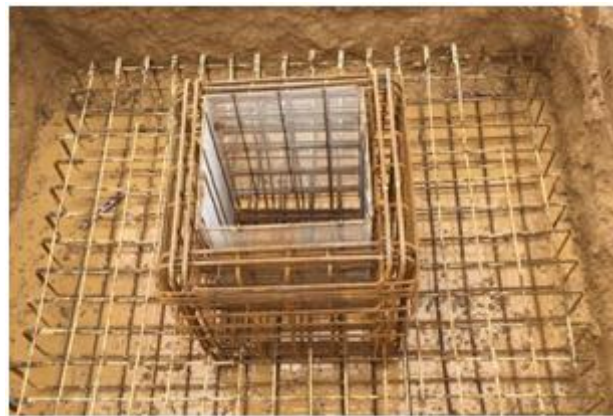
Figure II.2 : Encuvement d'un poteau [12].
