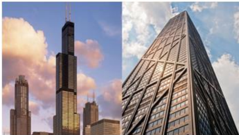
Figure IV.4 : La willis Tower à Chicago (USA) [12].
