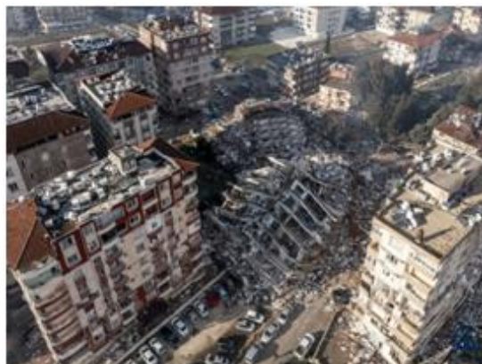
Figure IV.10 : Séisme du 6 février 2023 en Turquie [27].
