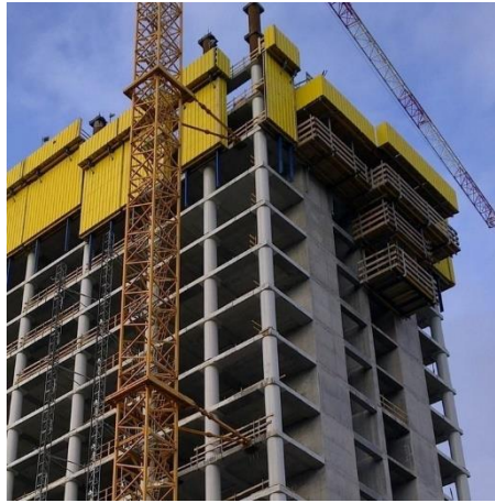
Figure II. 4 : Poteaux en acier d'un IGH en cours de construction [26].
