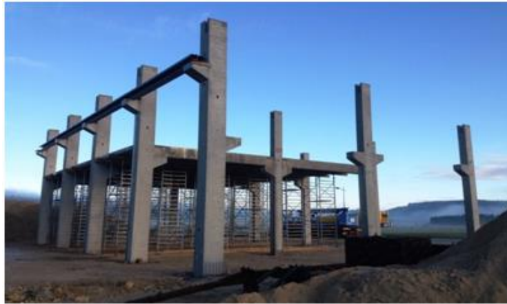
Figure II. 8: Poteaux en béton armé avec corbeaux [44].
