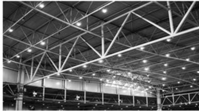
Figure II. 10 : Poutre en treillis [56].
