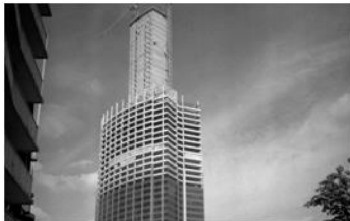
Figure III.4 : La tour de Montparnasse (France) en construction [9].
