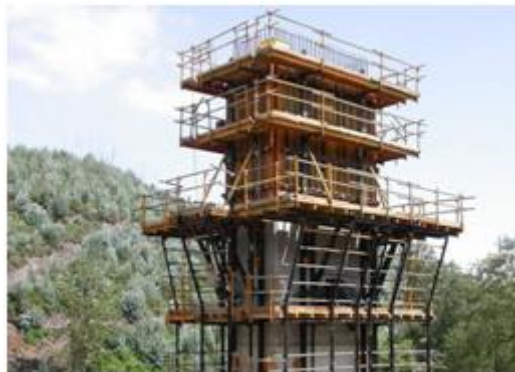
Figure V.3 : Coffrage glissant [14].
