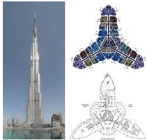
Figure IV.3 : La forme en Y de la Burj khalifa (UEA) [10].
