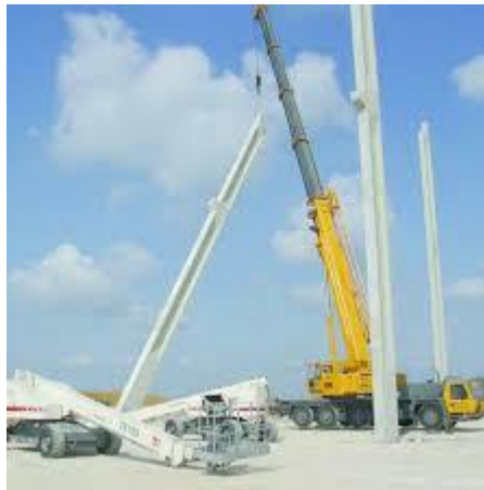
Figure II.3 : Mise en place d'un poteau en béton précontraint [4].
