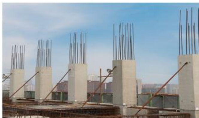
Figure II.1 : Poteaux en béton armé [4].
