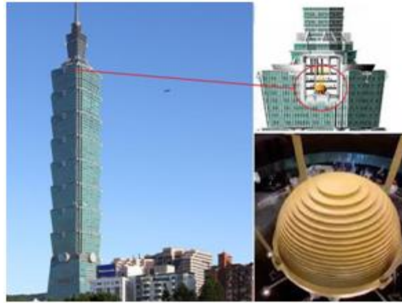
Figure IV.6 : L'emplacement de l'amortisseur de la Taipei 101[16].
