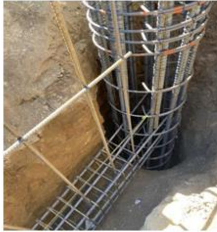
Figure II.34 : Caisson de fondation [144].
