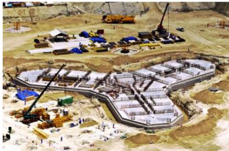
Figure II. 30 : Fondations du Burj Khalifa [129].
