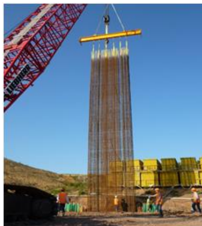
Figure II.32 : Barrettes en béton armé [133].
