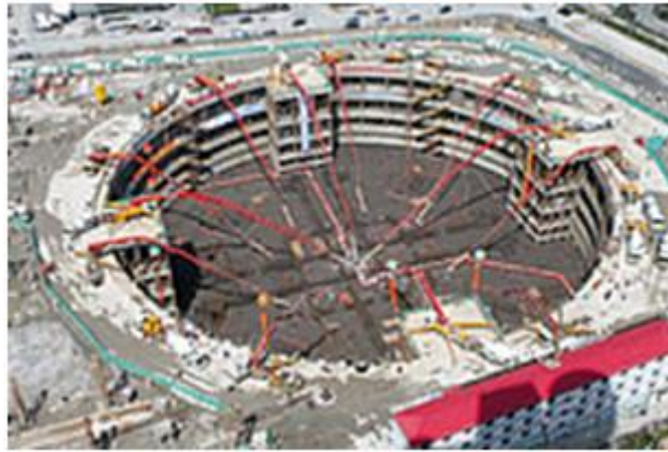
Figure II.31 : Les fondations du Shanghai Tower (Chine) [131].
