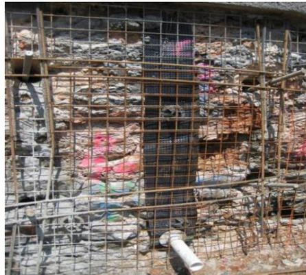
**Figure II.11:** L'installation de la bande de drainage avant la première mise en place du béton projeté.
