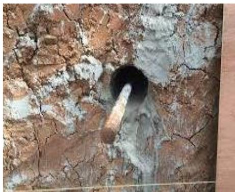
**Figure II.9:** Mise en place d'une barre d'acier après forage.
