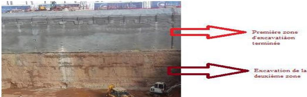
Figure II.13: Technique d'excavation par niveau ; niveau 1 terminé, niveau 2 commencé.
