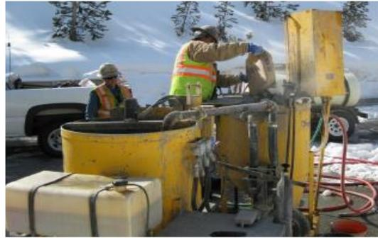
Figure II.19: Pompe d'injection et malaxeur de coulis de ciment.
