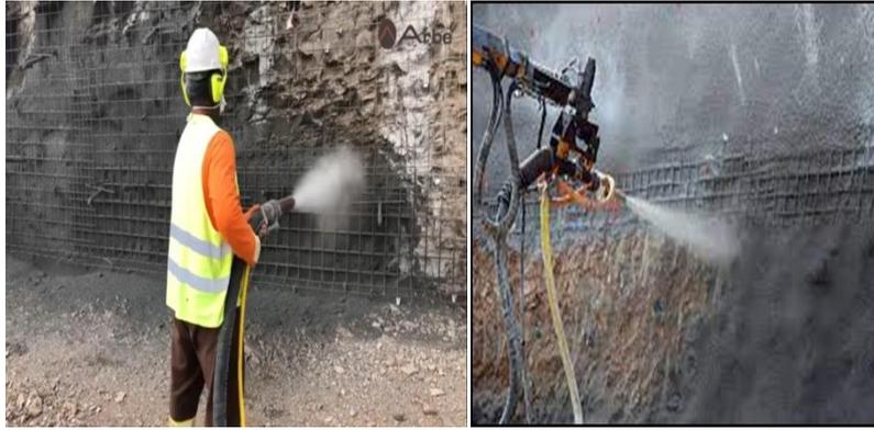
Figure II.12: Application de béton projeté avec treillis soudé.
