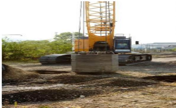
**Figure I.14:**Amélioration des sols par drainage vertical[5].
