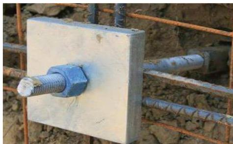
Figure II.21: Détails sur la tête des clous.
