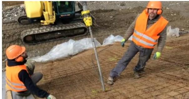
**Figure II.8:** Forage pour mise en place et scellement d'une barre.
