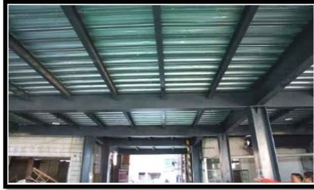
Figure III. 3 : Disposition des solives (net, 7)
