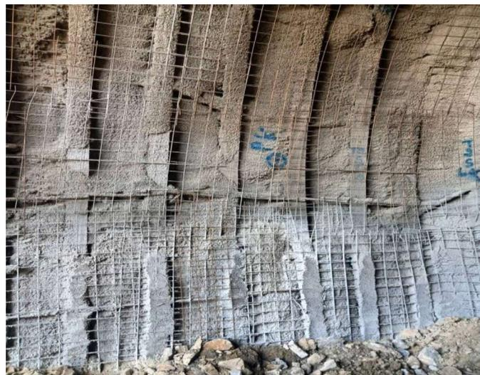
*Figure.III.8 Treillis soudé B500 sur chantier*
