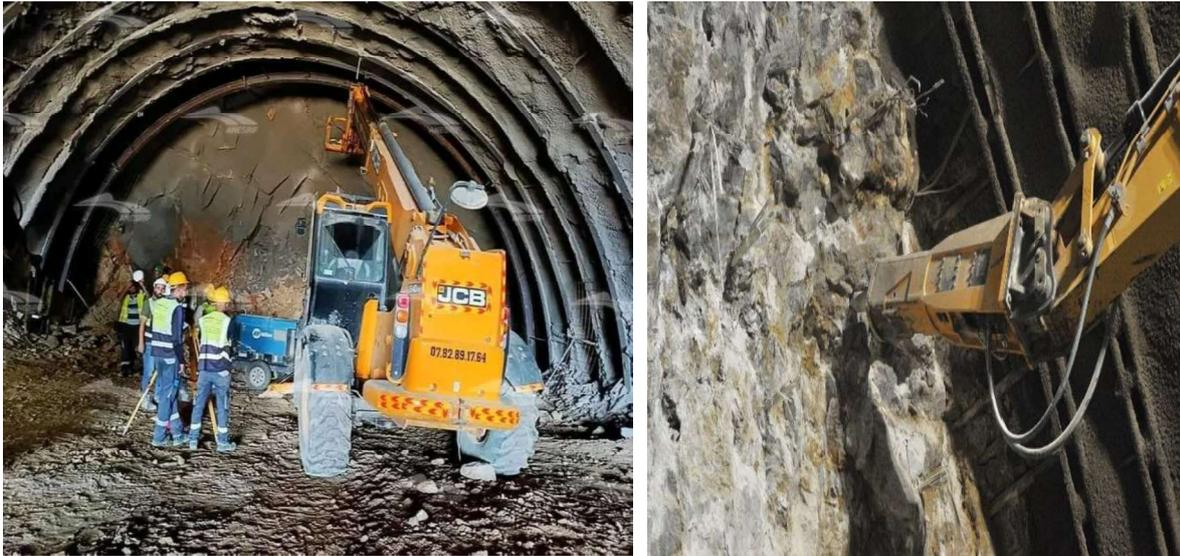
*Figure.II.14 Creusement au brise roche hydraulique*
