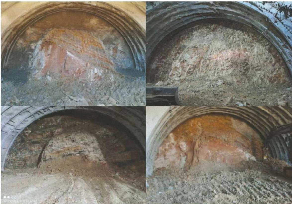
**Figure I.10** Les différentes classes de flysch rencontrées pendant le creusement [2]
