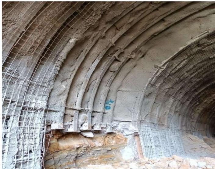
*Figure.III.10* Cintres HEB180 sur chantier du tunnel T2
