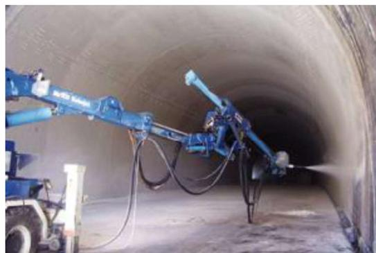
Figure.III.5 Opérateur de projection en voie mouillée [11]
