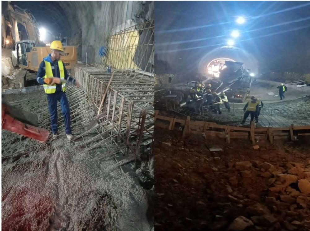
Figure.III.16 Coulagés de radier et banquettes les photos sur chantier
