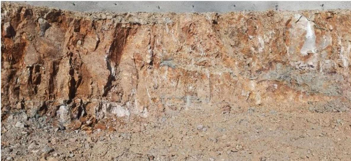
*Figure IV.1 Affleurement de l'entrée du tunnel T2 (Grès et argile numidiens)*
