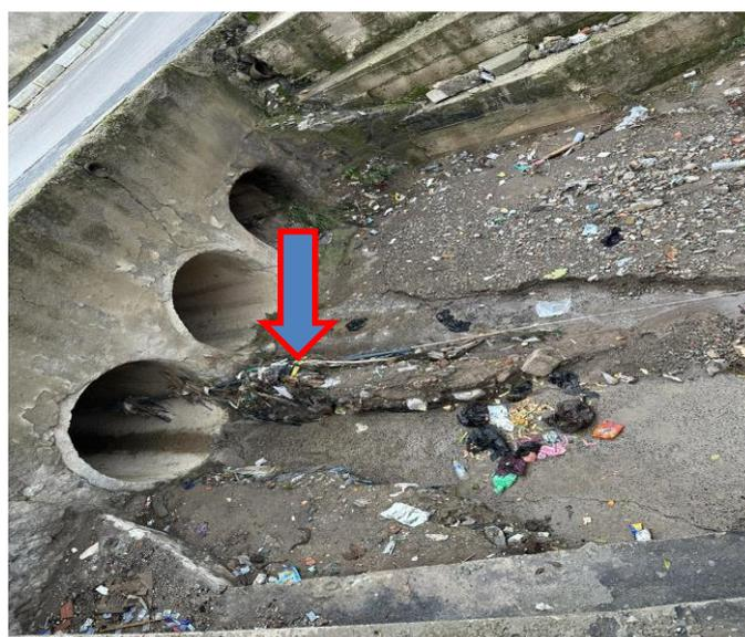
Figure 5.13 : colmatage des collecteurs des eaux pluviales à cause du transport solide.
