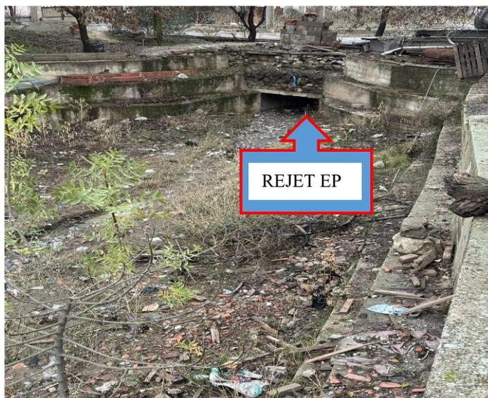
Figure 5.12 : Rejet des eaux pluviales de l'agglomération dans l'oued.
