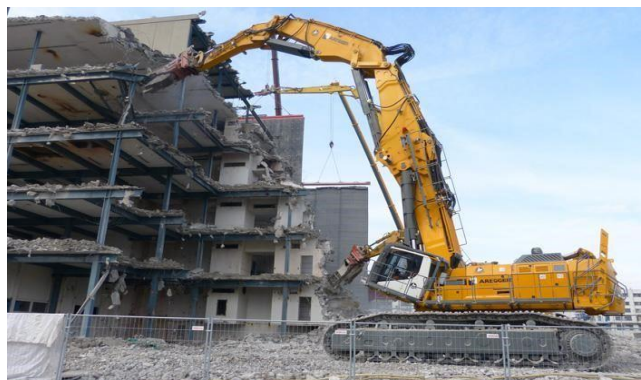
Figure II.3: Déchets de démolition
