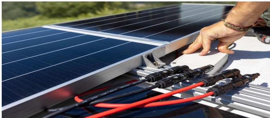
Figure (II.19) : exemple sur les câbles.
