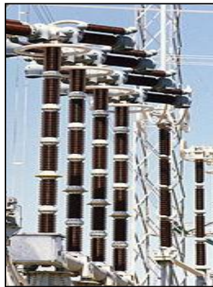
Figure II.5 : Disjoncteur à air comprimé.
