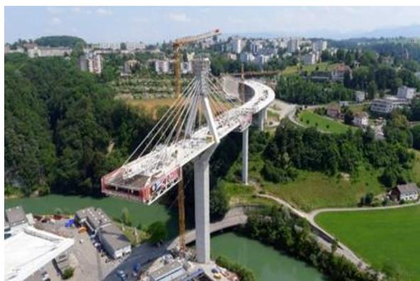
Fig. II. 10: Construction d'un pont à Haubans, (<https://implenia.com/fileadmin/implenia.com/leistungen/ingenieurbau/LP-6-5-P1020073.jpg>).
